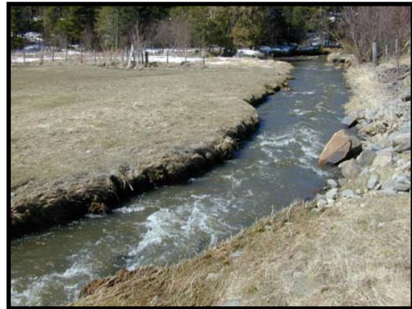
Figure 7. : Bande riveraine inadéquate
