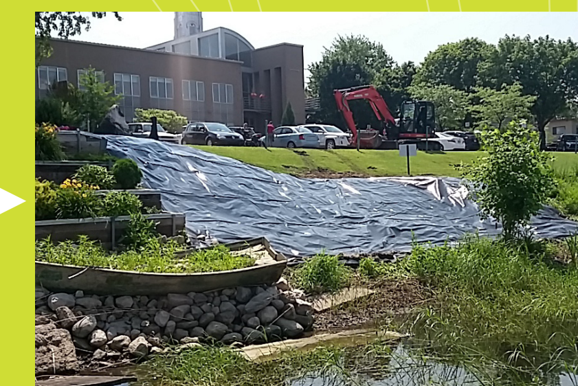
▲ Installed geomembrane © Comité ZIP des Seigneuries
