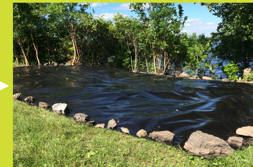
▲ Installed geomembrane © Comité ZIP des Seigneuries
