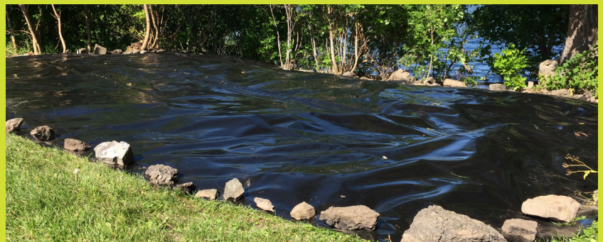
▲ Installed geomembrane © Comité ZIP des Seigneuries
