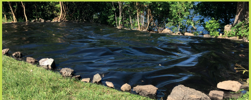
▲ Géomembrane installée © Comité ZIP des Seigneuries
