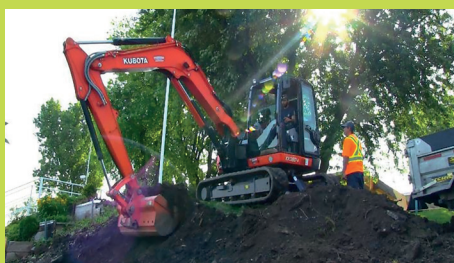
▲ Excavatrice mécanique © Denys Lortie
