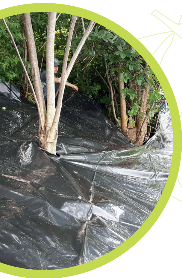
▲ Géomembrane installée © Comité ZIP Jacques-Cartier
