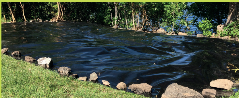
▲ Géomembrane installée © Comité ZIP des Seigneuries
