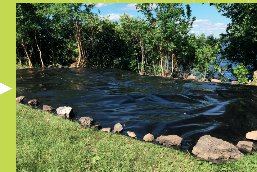
▲ Géomembrane installée © Comité ZIP des Seigneuries
